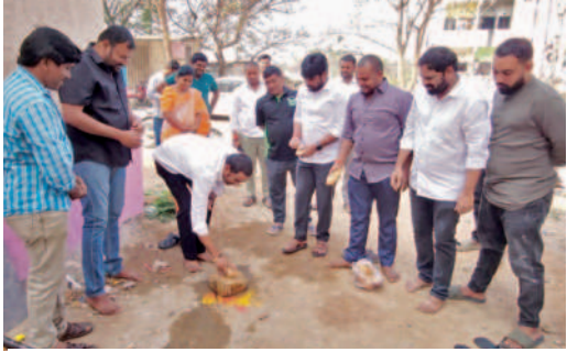
సినిరోడ్డు పనులు ప్రారంభిస్తున్న కౌన్సిలర్ శంభీపూర్ క్రిష్ణ
